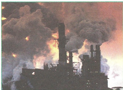
Рис. 98. Сжигание топлива — главный источник загрязнения атмосферы
