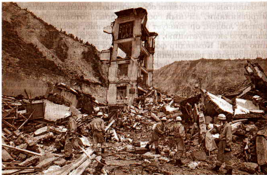
Рис. 22. Аварийно-спасательные работы после обрушения здания
