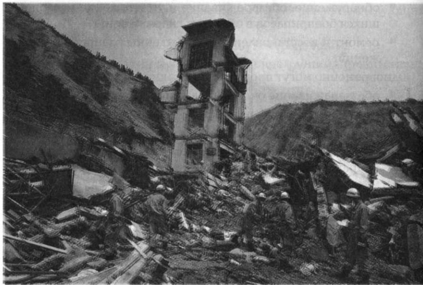
Рис. 43. Аварийно-спасательные работы после обрушения здания
