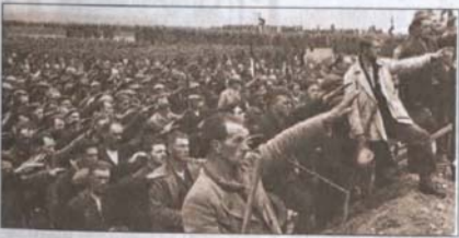
Рабочие на строительстве автомобильной дороги. Германия. 1934
